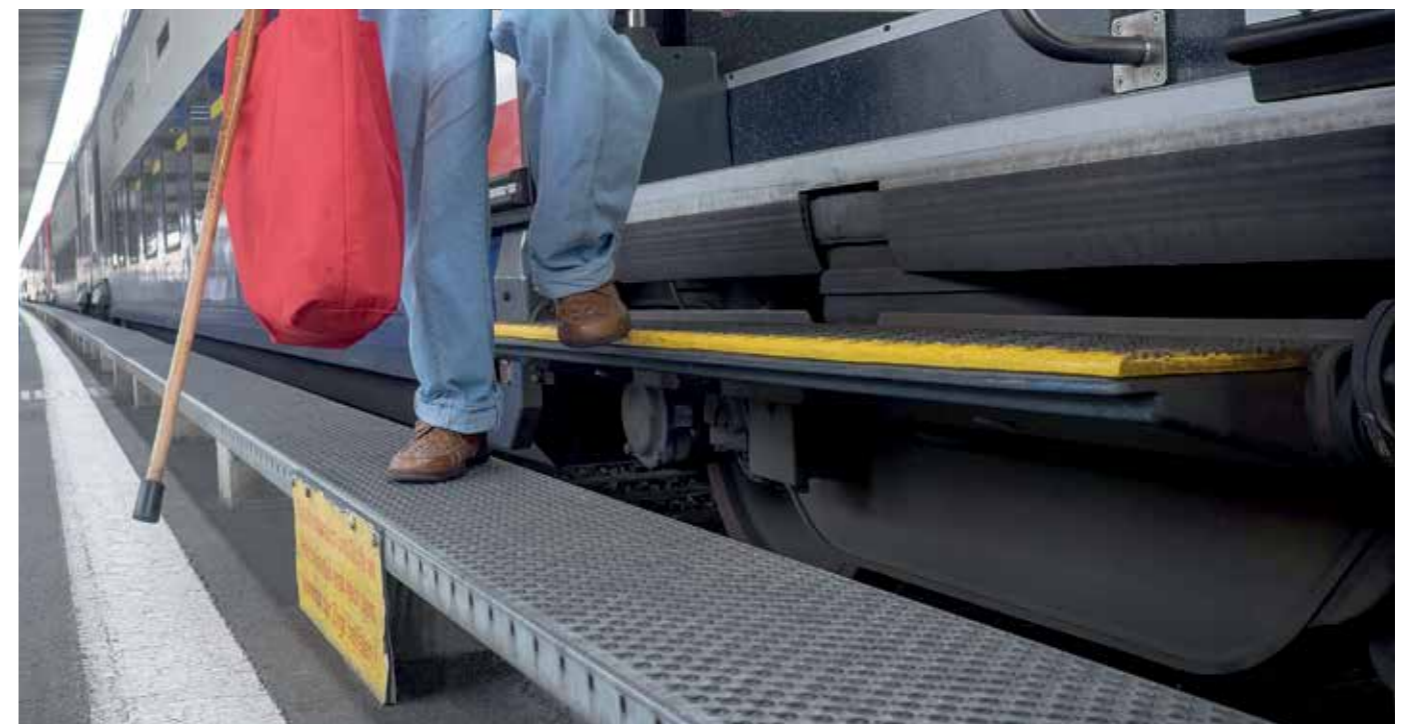
Beispiel eines Zustiegs, der nicht behindertengerecht ist: Perronkante und Einstieghöhe der Fahrzeuge müssen aufeinander abgestimmt sein, damit ein autonomer Zustieg auch für Rollstuhlfahrende und Gehbehinderte möglich ist.
